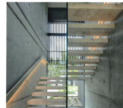
Als Kontrast dazu sind die Seitenwände des Erdgeschosses mit Sichtbetonplatten verkleidet. Im Innern werden diese Materialien fortgeführt – die Brüstung der Galerie ist mit der schwarzen Holzlattung versehen und analog die Decken und die Treppenhauswände mit Sichtbeton ausgeführt. Geheizt wird mit einem Gaskamin in Abwechslung mit einer Lüftungsanlage mit Wärmerückgewinnung.
