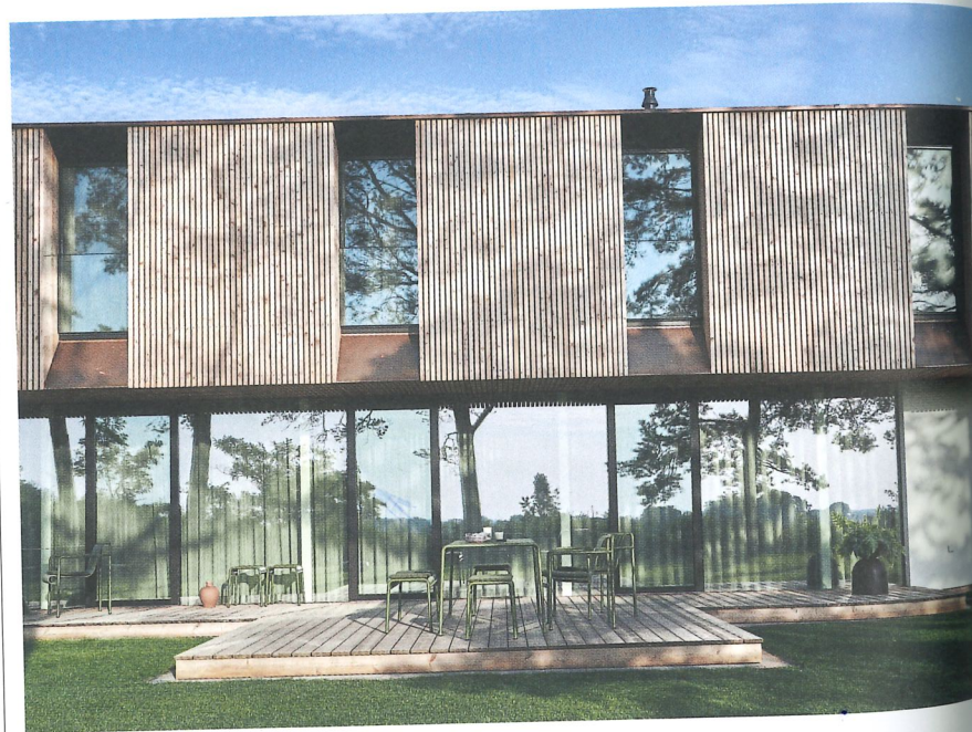
Kitchen and dining area. A bedroom. Exterior view with terrace. Küchen- und Essbereich. Schlafzimmer. Außenansicht mit Terrasse.
